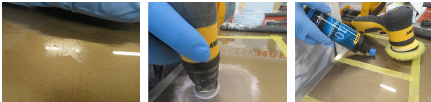
Imagen11: Eliminación de marcas de poliuretano
