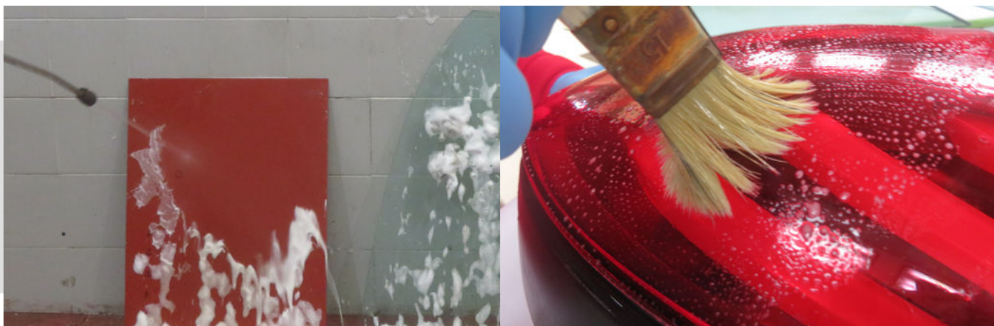
Imagen 7: Eliminación con agentes espumantes y con productos desincrustantes
